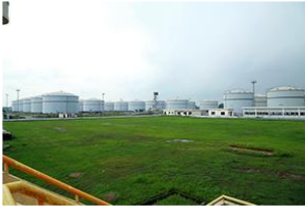
Fig.8: Muthurajawela LNG Terminal
